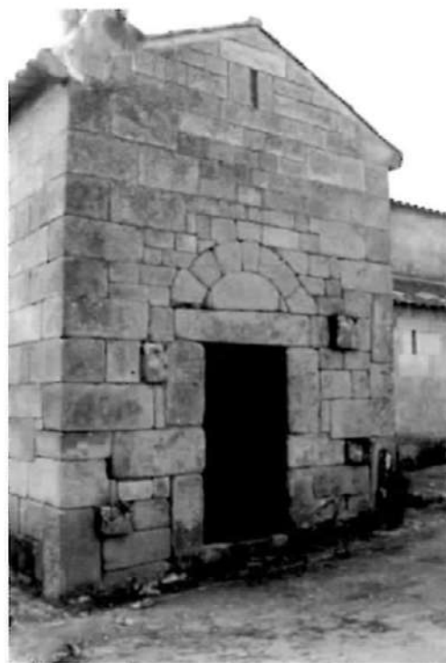
Figura 21 – Fachada norte da nave transversal da igreja de São Pedro de Lourosa, com portal de lintel recto com arco de descarga de volta perfeita.
