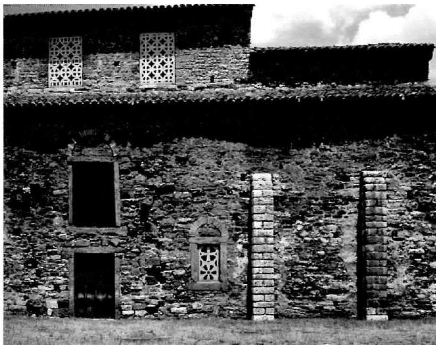
Figura 22 – Vista parcial da fachada lateral sul da igreja de San Pedro de Nora.
