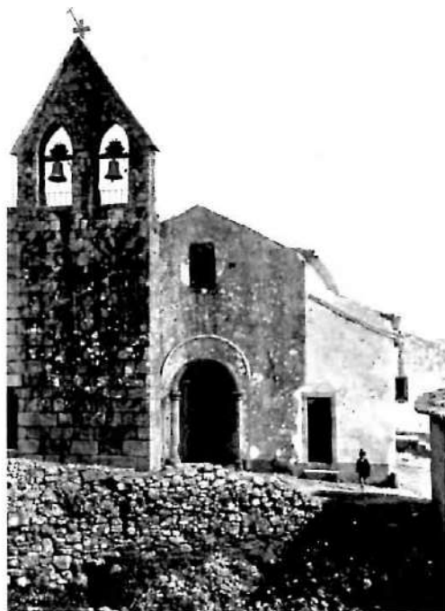
Figura 13 – Fachada principal da igreja de São Pedro de Lourosa, antes do restauro. Fot. de Marques de Abreu, publ. por Manuel de Aguiar Barreiros (1934).
